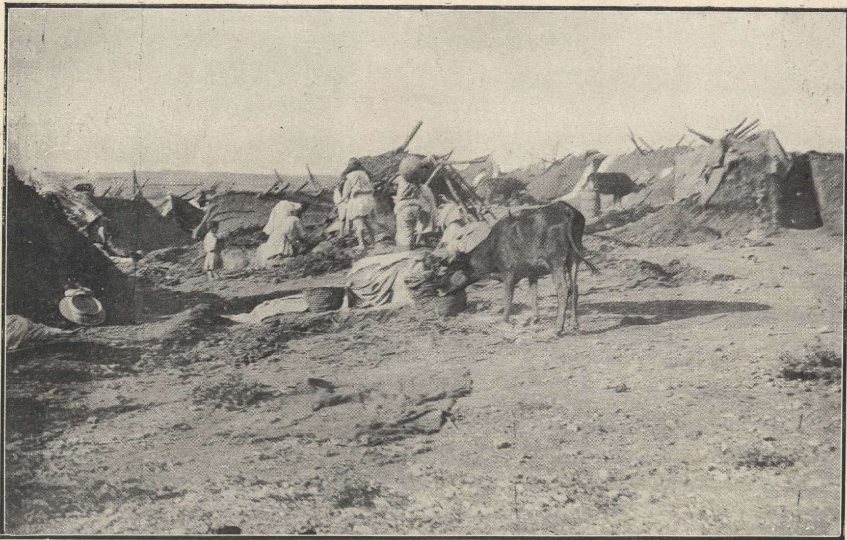
RECOMPOSICION DE CHOZAS QUE DESTROYERON LAS LLUVIAS POR LOS MOROS NEUTRALES HABITANTES CERCA DEL FUERTE DE CAMELLOS
