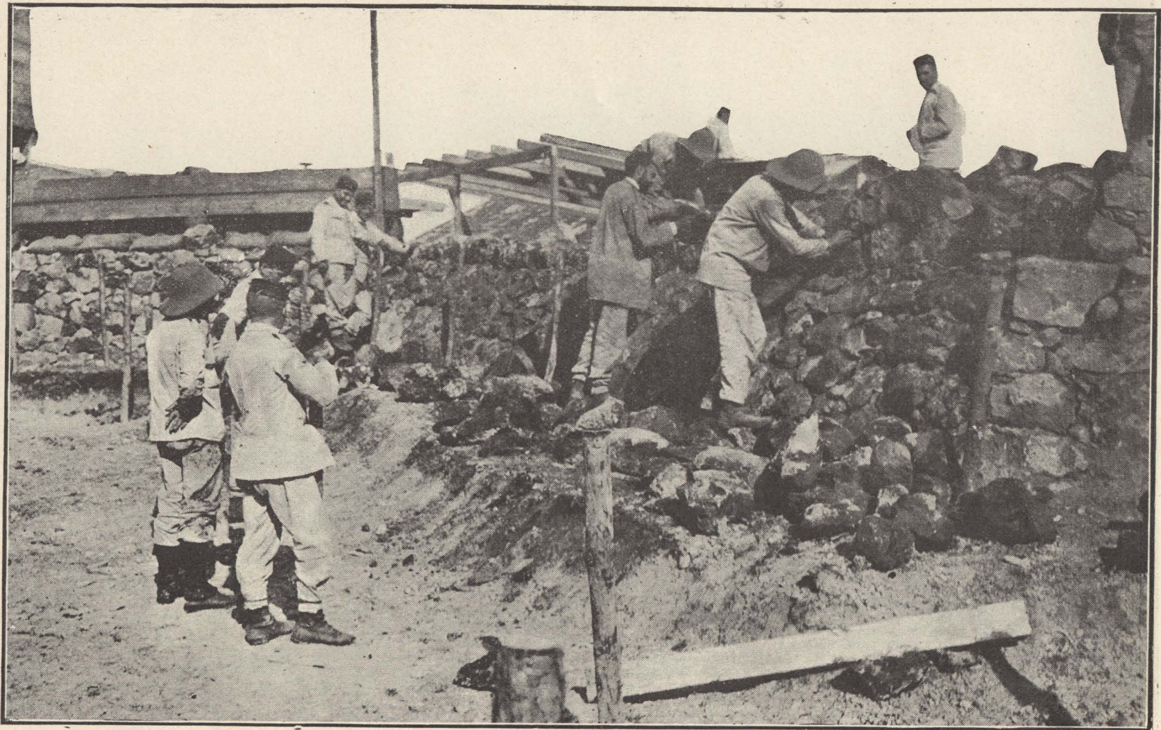
TRABAJOS DE CONSTRUCCIÓN DE «BLOCKAUS» EN LOS CÁMPAMENTOS DE HINDUM, RECIENTEMENTE CONQUISTADOS
