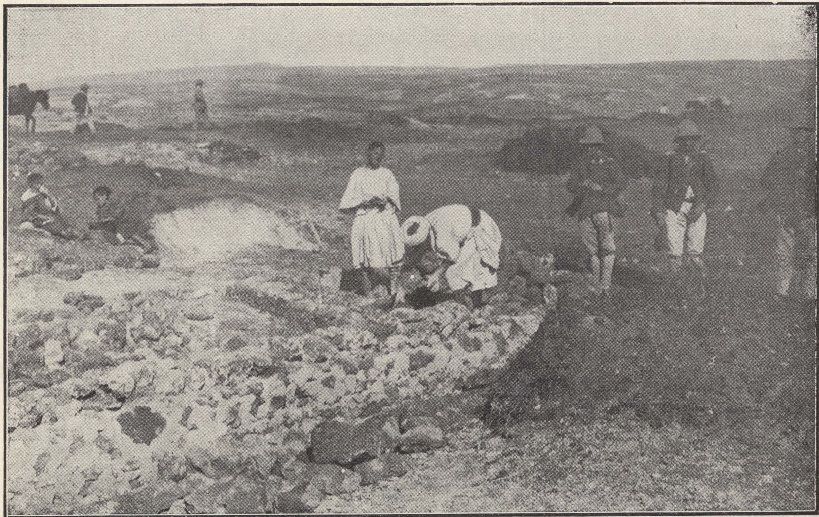
FAM'LIA MORA RECOGIENDO MATERIALES CON QUE REPARAR LOS DEFECTOS DE SU CASA DESPUÉS DE UN BOMBARDEO
