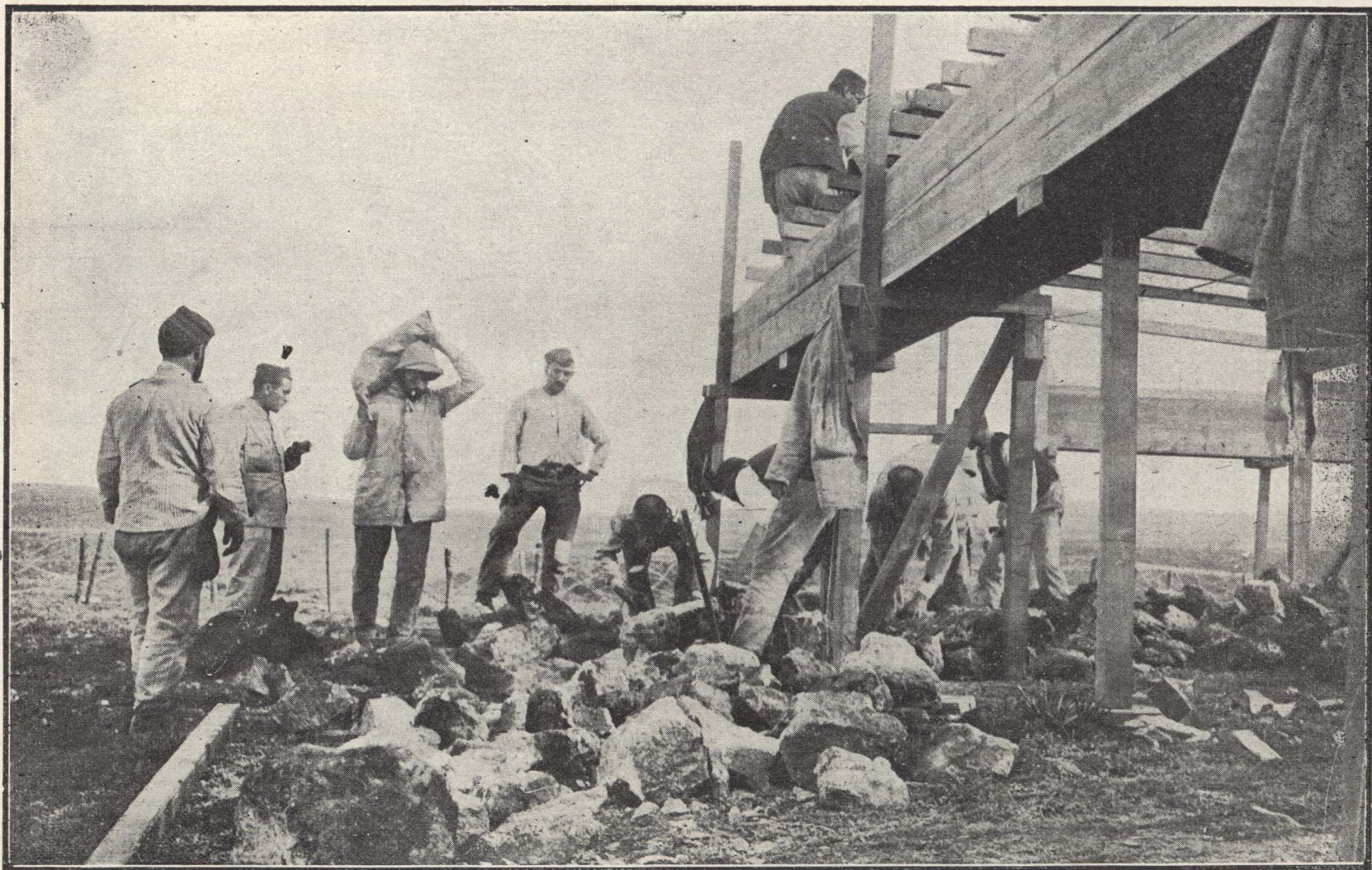
NUESTRAS TROPAS CONSTRUYENDO UN BARRACÓN EN EL CAMPAMENTO DEL ZOCO-EL-HAD
